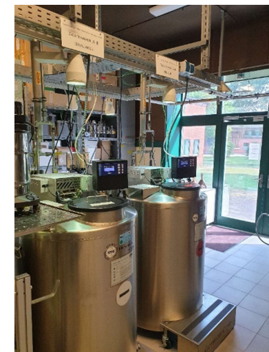
Innenraum mit Containern
